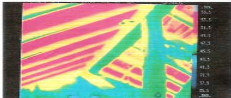
3. 充填断熱の場合の小屋裏の屋根下地材(野地板)の熱画像
