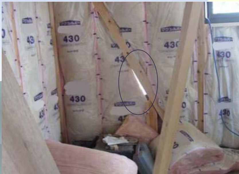
筋交部の断熱欠損
